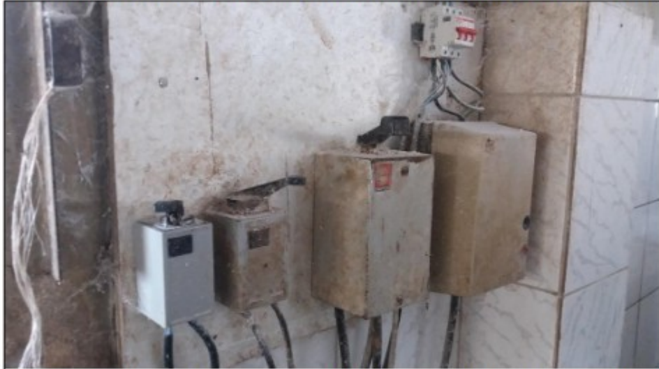
Imagens: Comandos de partida de máquinas da linha de produção, chaves tipo “Lombard”.
