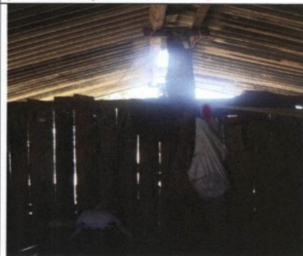
Foto: Comunicação direta do interior do paio com o ambiente exterior. Impacto de intempéries, sujidades e animais.
