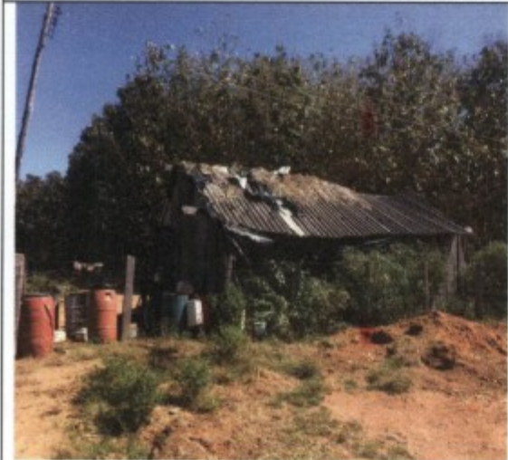
Foto: Paiol onde dois trabalhadores dormiam e viviam na Fazenda Pedra Preta.
