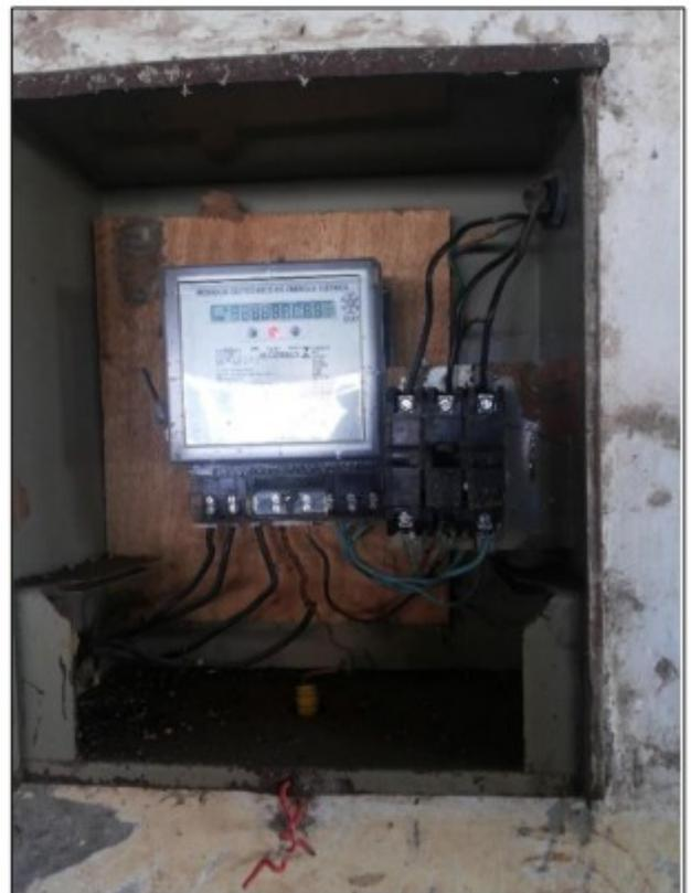
**Imagens:** Máquinas e equipamentos utilizados na casa de farinha, com zonas de perigo expostas e sistemas elétricos que acarretavam riscos de choque e outros acidentes.
