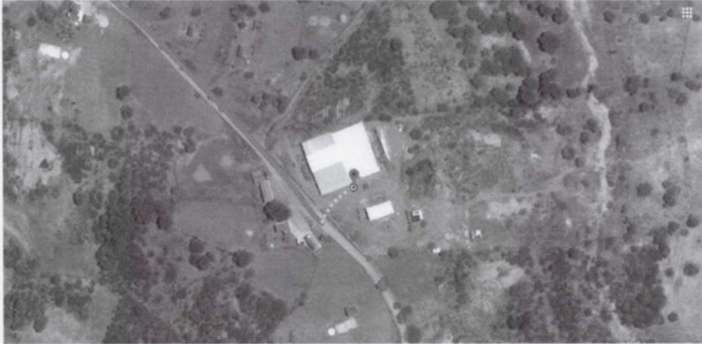
IMAGEM 4: Vista área do deslocamento na estrada de terra, estando o estabelecimento à esquerda (frente murada).
