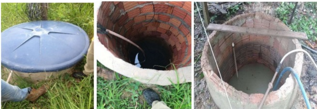
Fotos 1 e 2: dois poços de onde era retirada a água consumida pelos trabalhadores.
