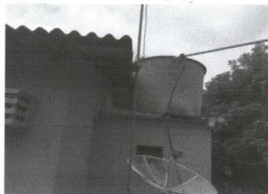
Foto 03: Caixa de água abastecida por poço artesiano
