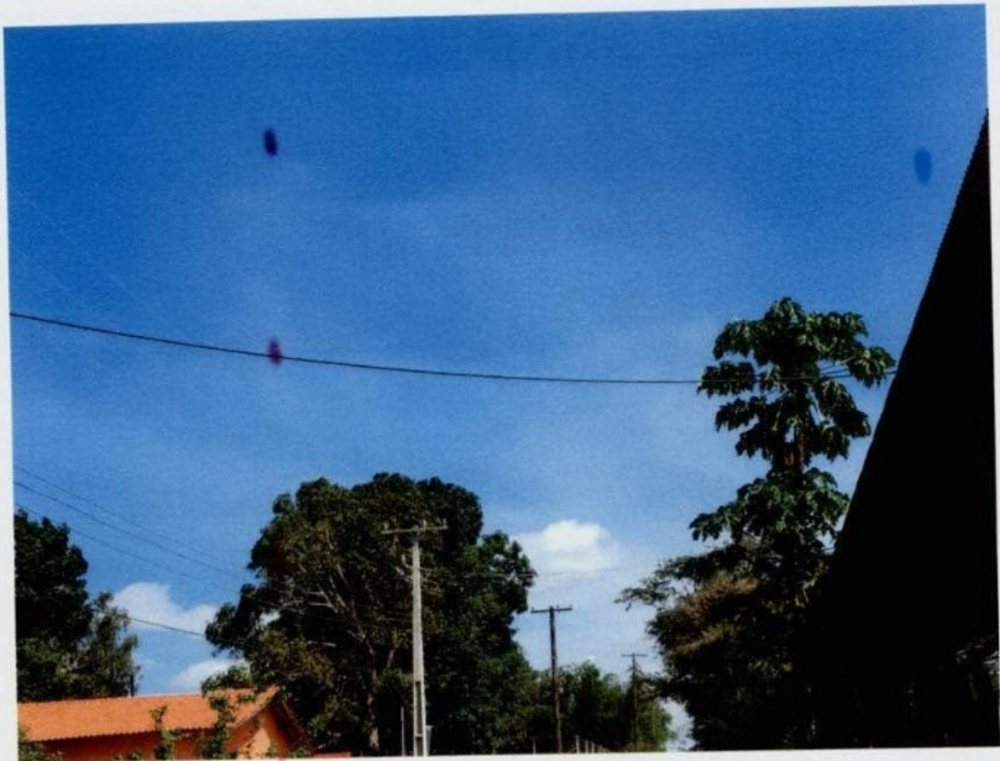
Figuras 07 e 08 – Fio indo do Poste da Rua ao estabelecimento.
