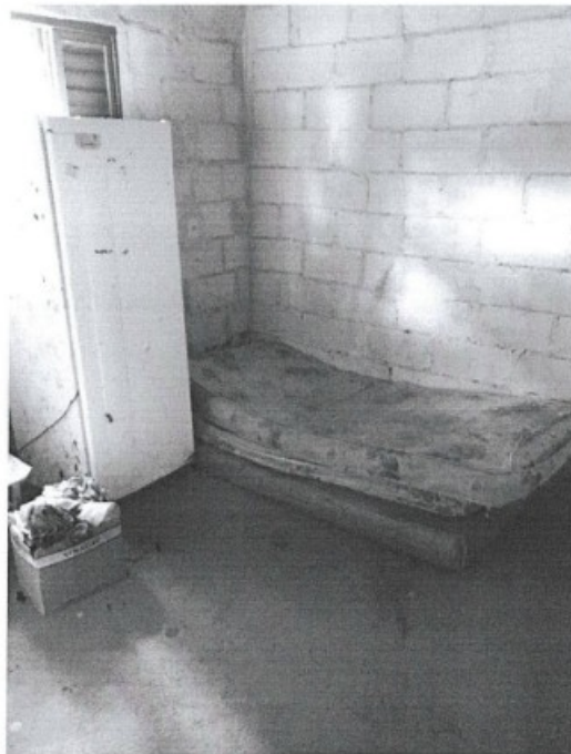
17.05.2018 - Foto do alojamento dos trabalhadores - Itú/SP
