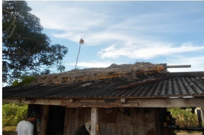
Detalhe da cobertura de palha do alojamento do senhor [REDACTED]
