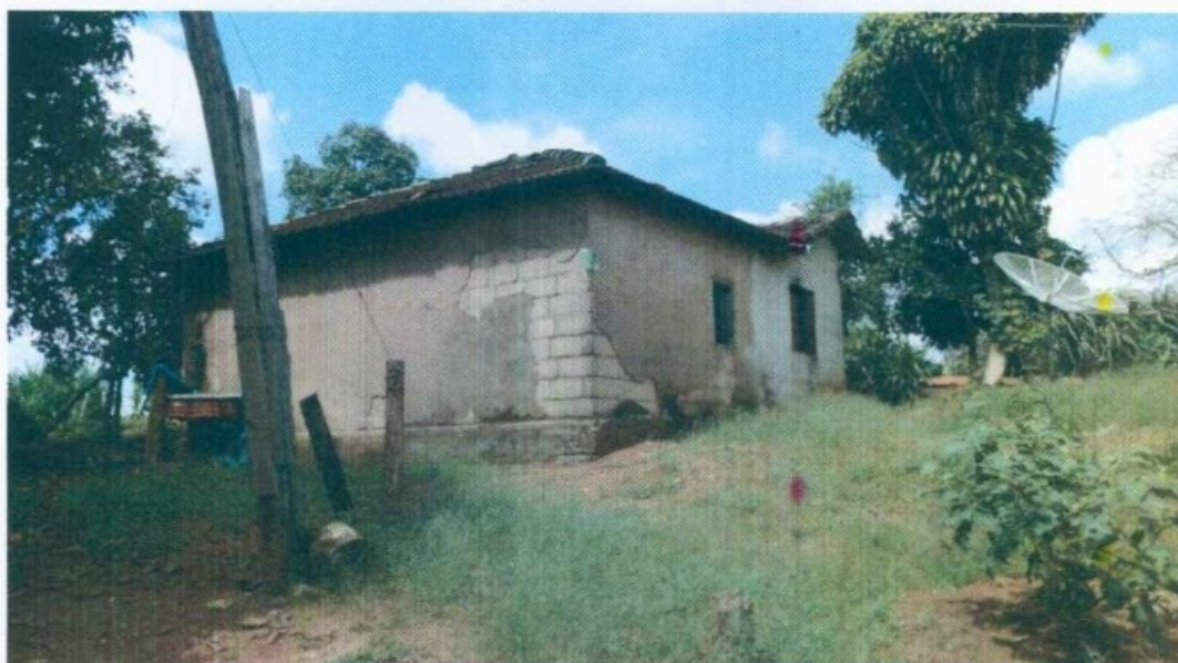
*Vista externa da moradia disponibilizada ao trabalhador
