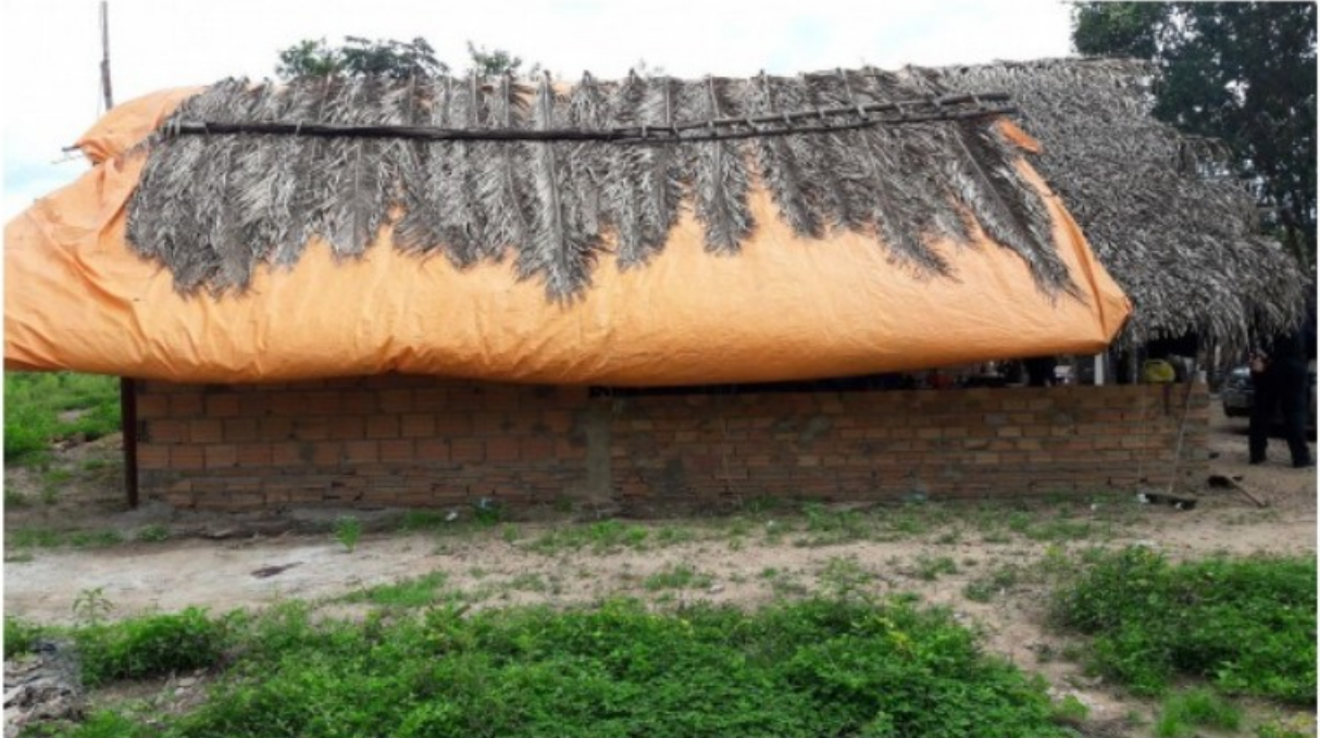
Foto 04 – Instalação construída à título de alojamento, com teto de lona e palha.
