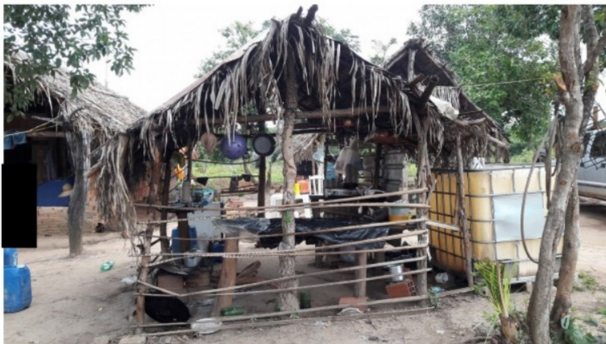
Foto 08 – Instalação precária utilizada para o preparo de alimentos e armazenamento dos gêneros alimentícios.
