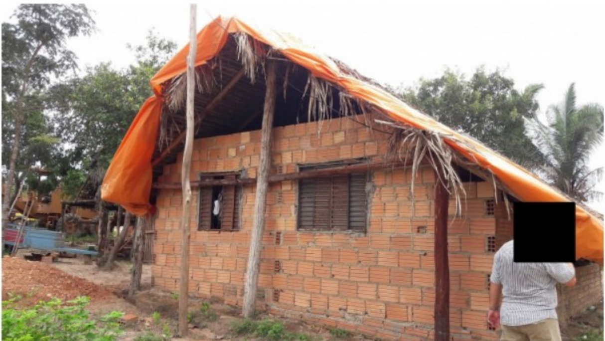
Foto 05 – Instalação destinada ao alojamento.
