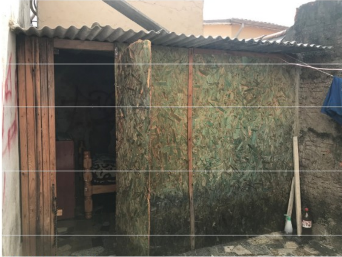
28-03-2018. Alojamento da [REDACTED] barraco erguido com folhas de madeirite e coberto de telhas de amianto.
