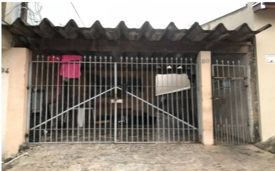
28/03/2018 – Imagem externa do imóvel onde o empregador alojava os trabalhadores.
