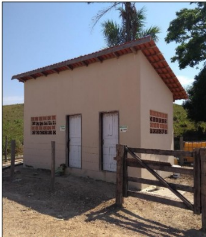
Foto 1: local que servia de depósito de agrotóxicos.
