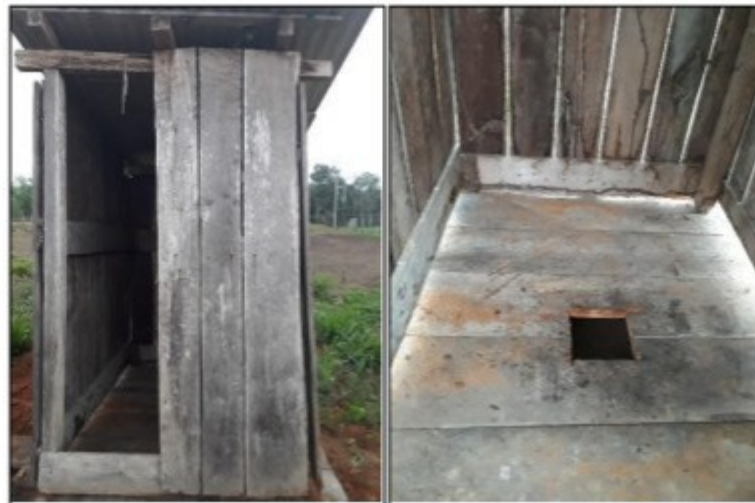
Fotos 11 e 12: local construído como instalação sanitária próximo à casa das pulgas.
