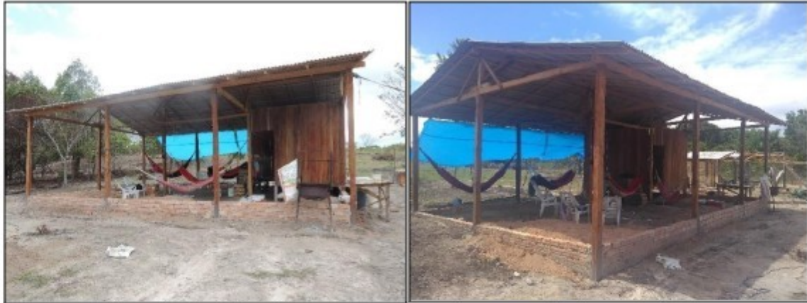
Fotos 1 e 2: edificação em construção onde estava alojado o trabalhador.
