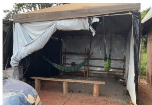
Dormitório com paredes de lona preta.
