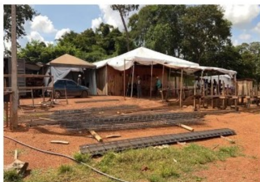
Alojamento e canteiro de obra juntos.
