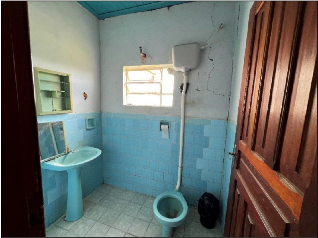
Foto 28 – Banheiro do alojamento
