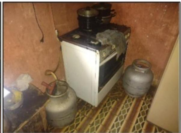
Fotos 39 a 45 – Fotos da Cozinha . Nas imagens verificamos a um fogão de quatro bocas e outro fogão de 6 bocão, ambos eram alimentados por botijão de gás GLP que estavam instalados na área interna e não ventilada do alojamento.
