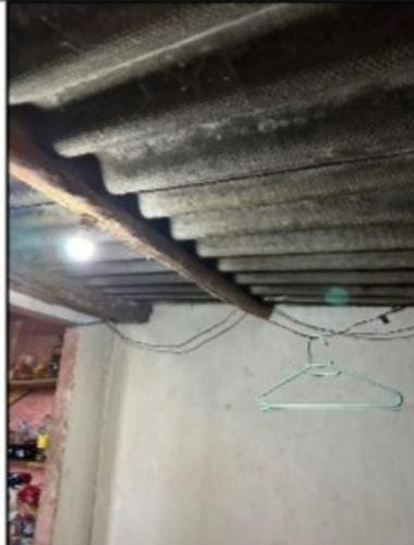
Fotos 22 a a 29 – Instalação elétrica improvisada, com partes vivas exposta e com risco de incêndio e choque elétrico.
