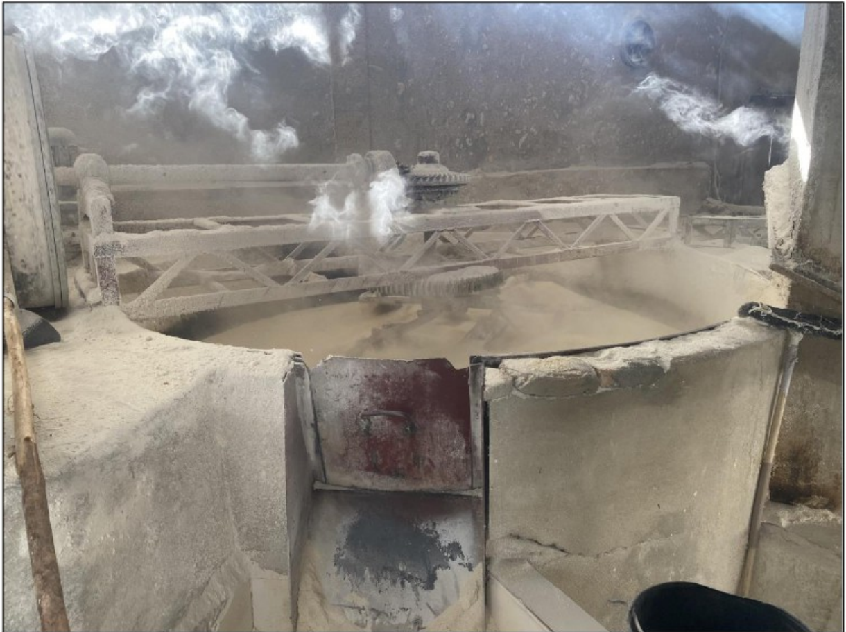
Imagens acima: Zonas de perigo das máquinas (rosca sem fim e pás de um dos fornos) sem qualquer proteção.
