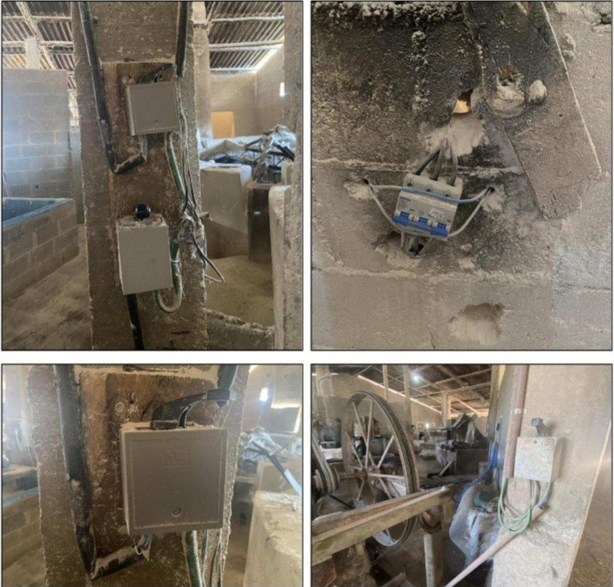
**Imagens acima:** Disjuntores e chaves tipo "Lombard" que eram usados para acionar as máquinas e equipamentos da Fábrica.
