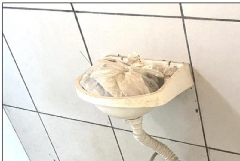
**Imagem:** O lavatório de uma das instalações sanitárias não possuía torneira.
