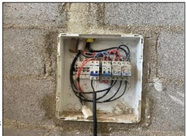
**Imagens acima:** As instalações elétricas da Fábrica estavam em precário estado de conservação e acarretavam riscos de choques e outros acidentes.
