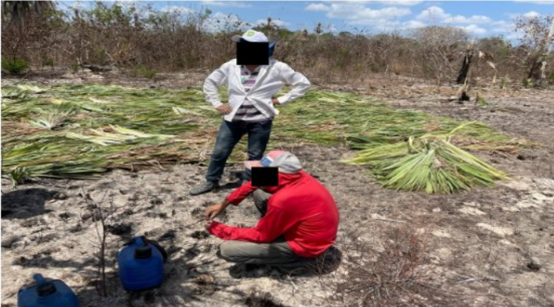
Ausência de área de vivência na frente de trabalho
