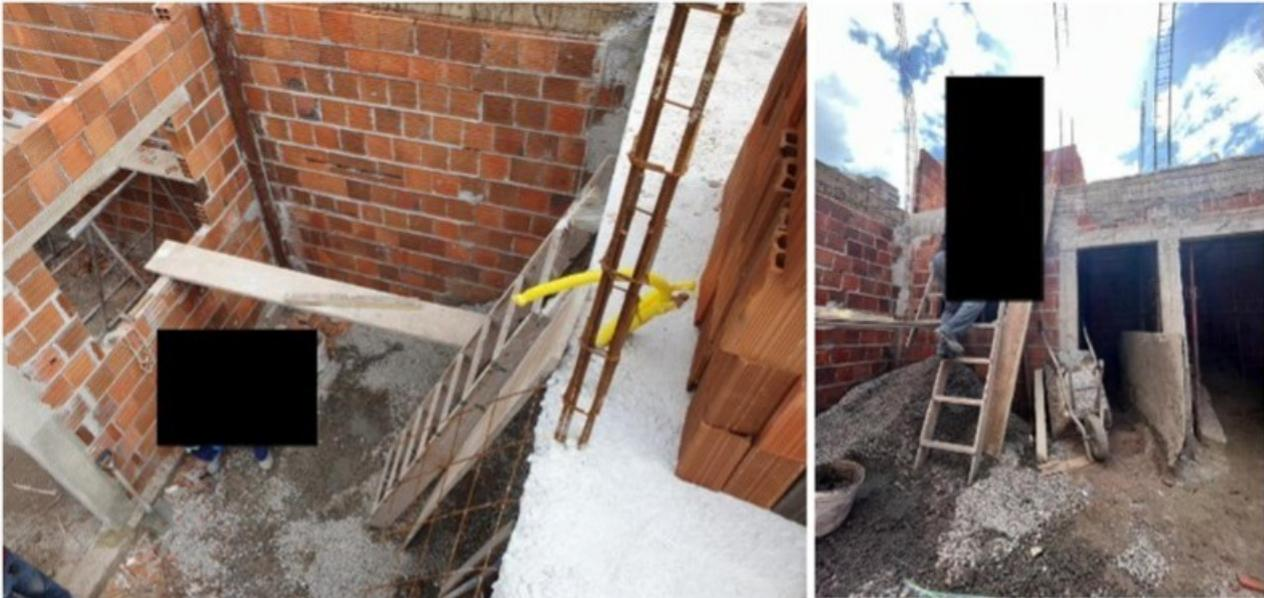
Figuras 9 e 10: Escada sem proteção/Risco de acidente por quedas de trabalhadores
