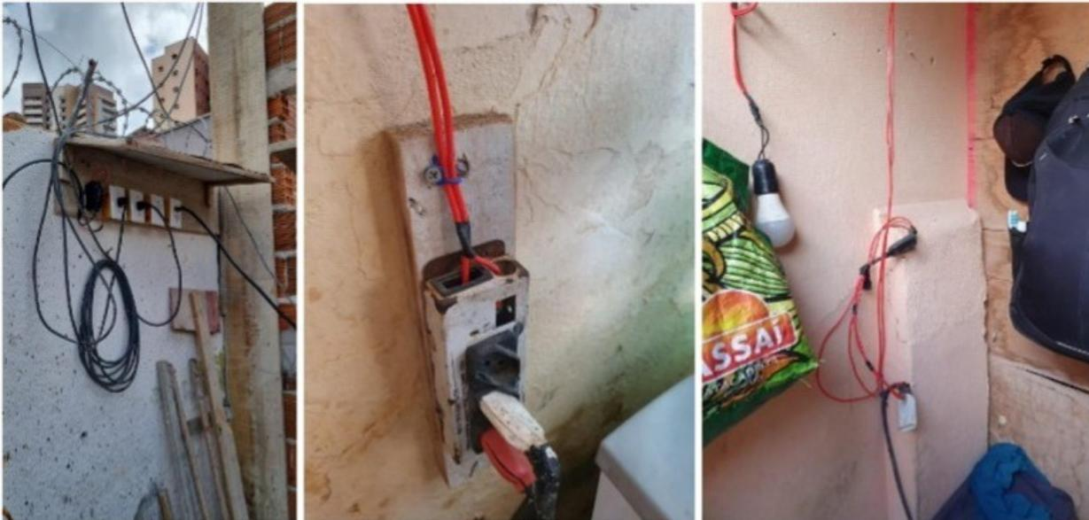
Figuras 11 a 13: Quadro de distribuição das instalações elétricas em desacordo com o disposto no subitem 18.6.10 da NR 18 e fiação com risco de choque elétrico.
