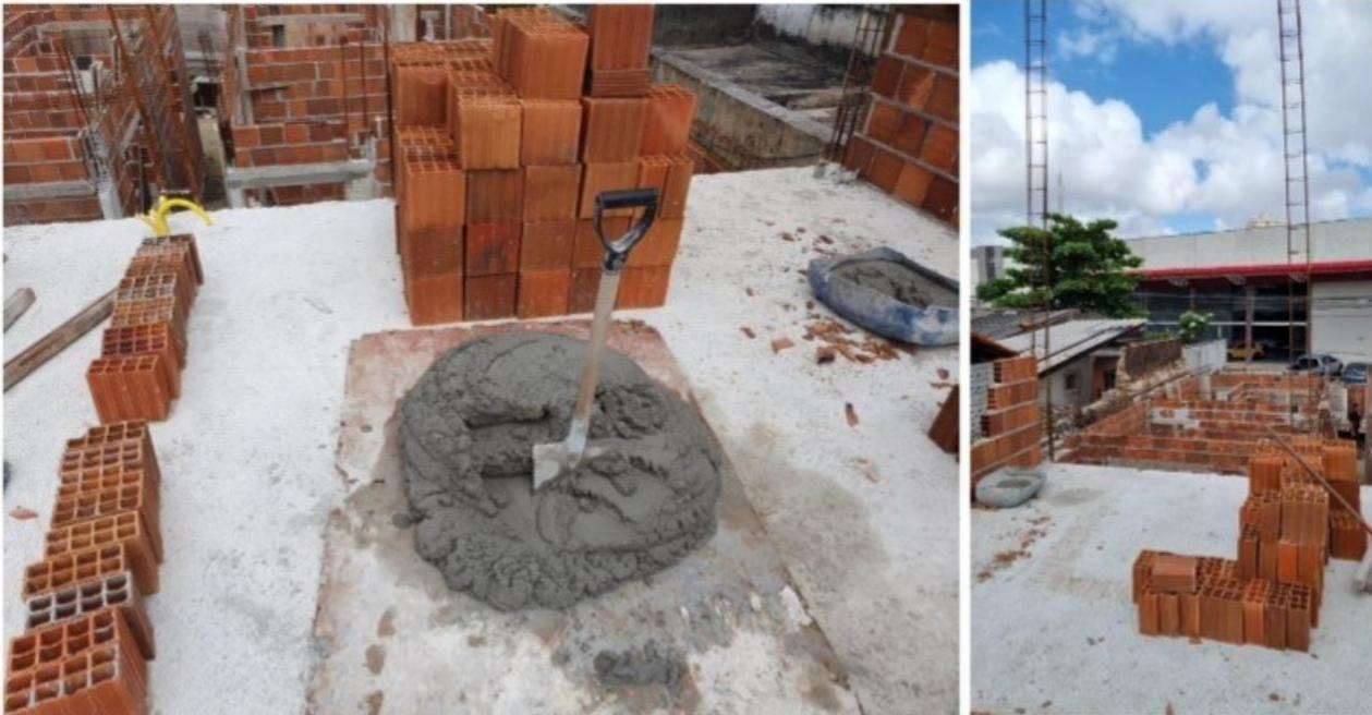
*Figuras 3 a 6: Falta de proteção coletiva onde houver risco de queda de trabalhadores ou de projeção de materiais ou objetos no entorno da obra.*
