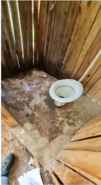
Interior da instalação sanitária, com paredes de ripas e piso deteriorado
