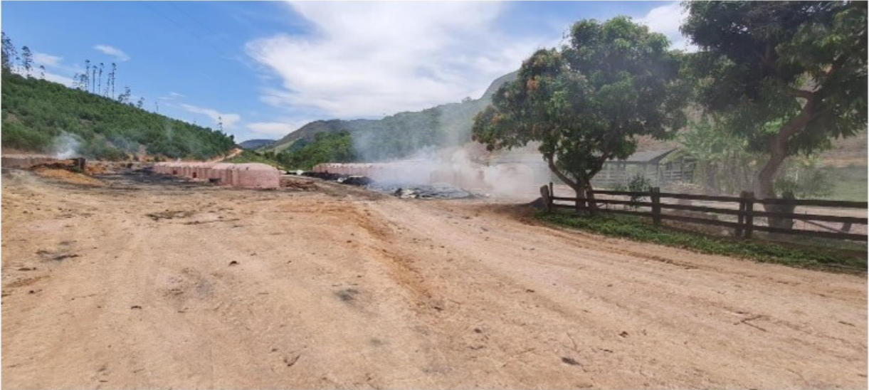
Vista geral da bateria de fornos
