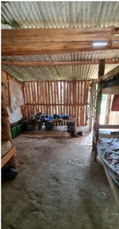
Dormitório com paredes de ripas, telhas de amianto, piso irregular, camas improvisadas, colchões velhos e rasgados
