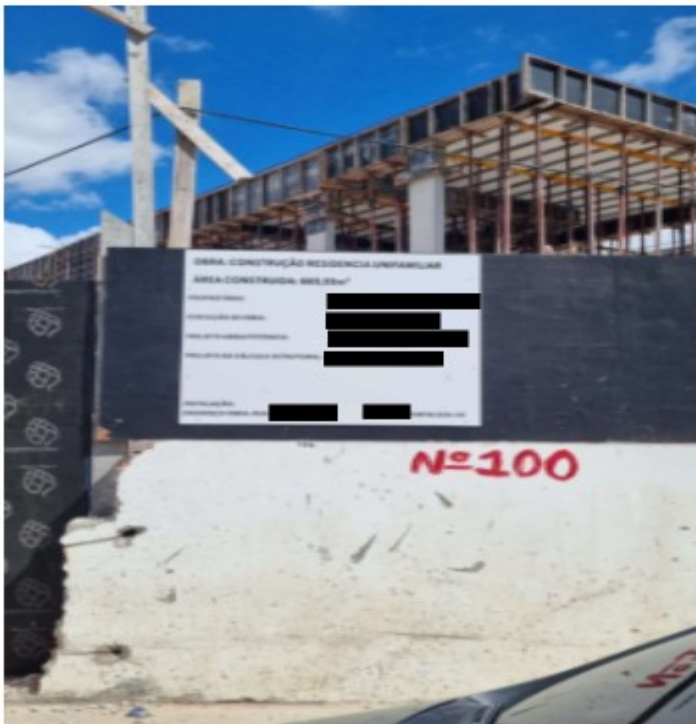
Figura 1: Inspeção no local de trabalho
