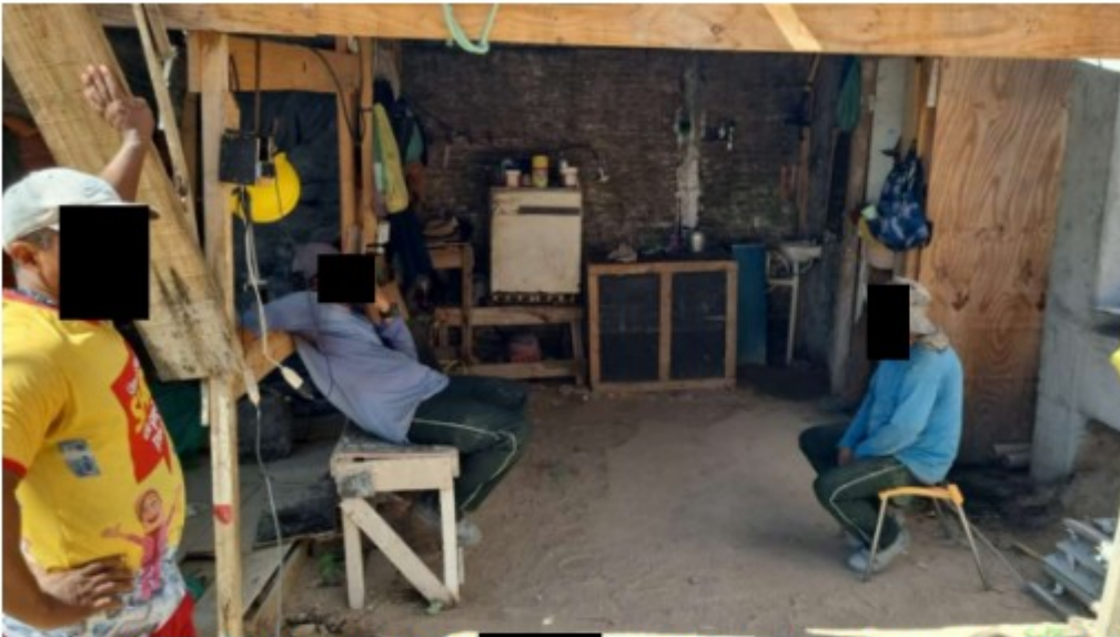
Figura 13: Local onde o empregado [REDACTED] armava sua rede para dormir. Fiação elétrica exposta. Locais improvisados de guarda de materiais.
