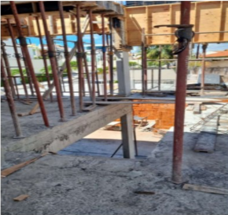
Figura 5: Local com abertura de piso
