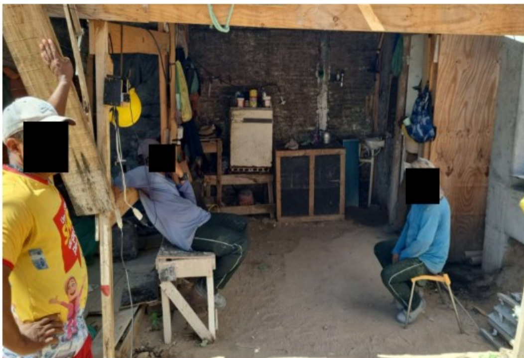
Figura 9: Ausência de EPIs.
