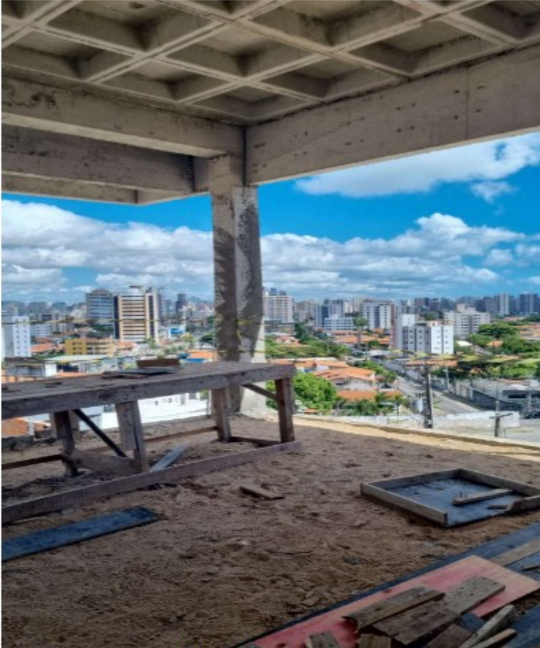
Figura 2: Inspeção no local de trabalho
