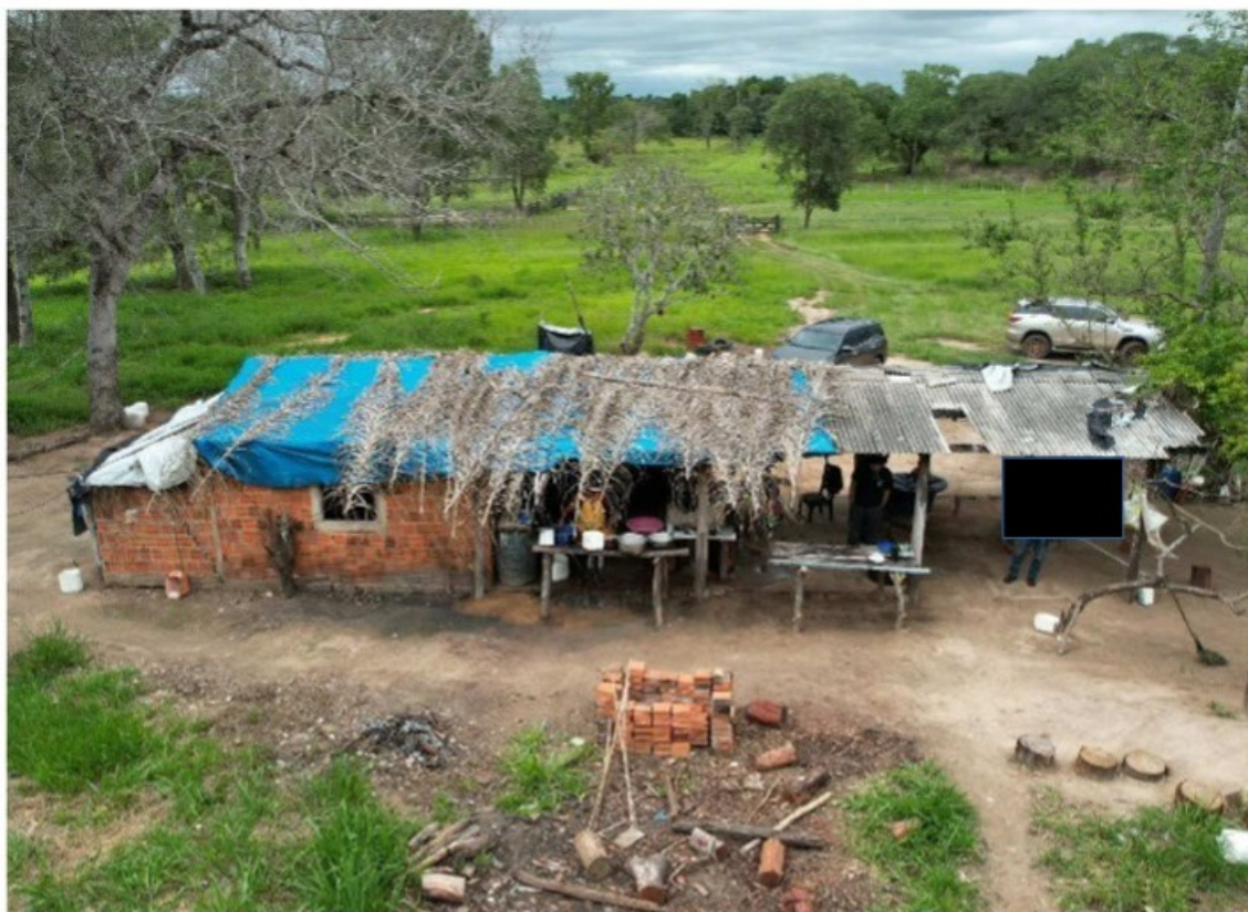
Foto 04: Vista Externa da Cozinha e Local para Refeição Disponibilizados aos Trabalhadores
