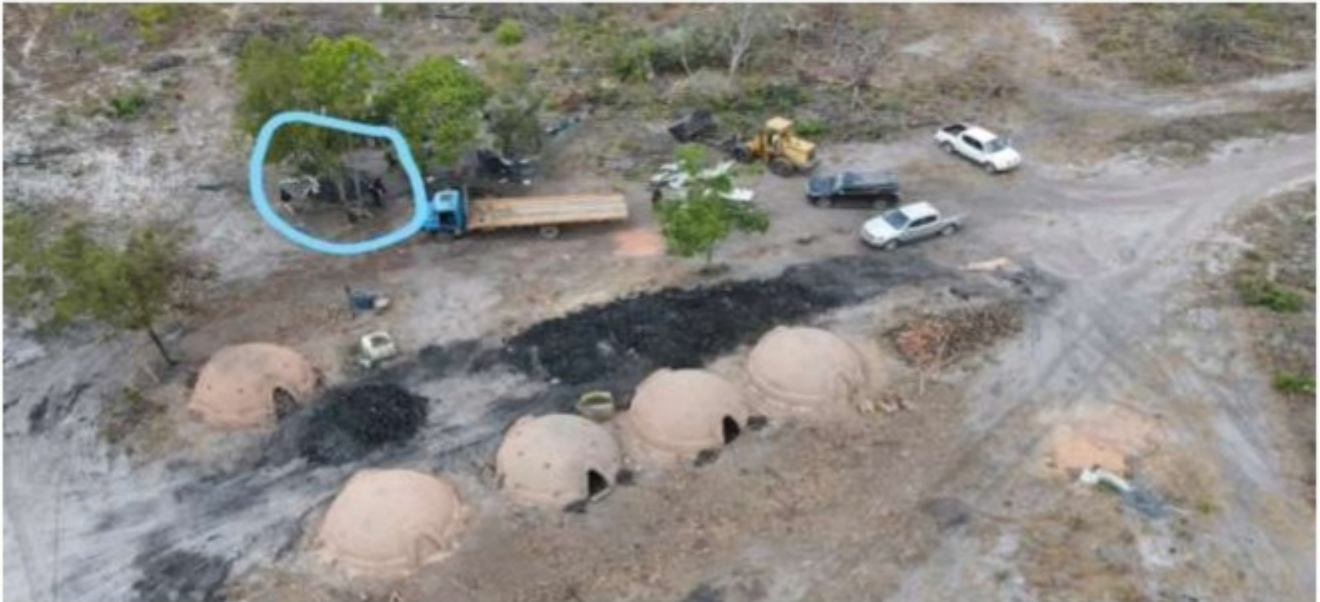
Localização do Barraco 2 na carvoaria
