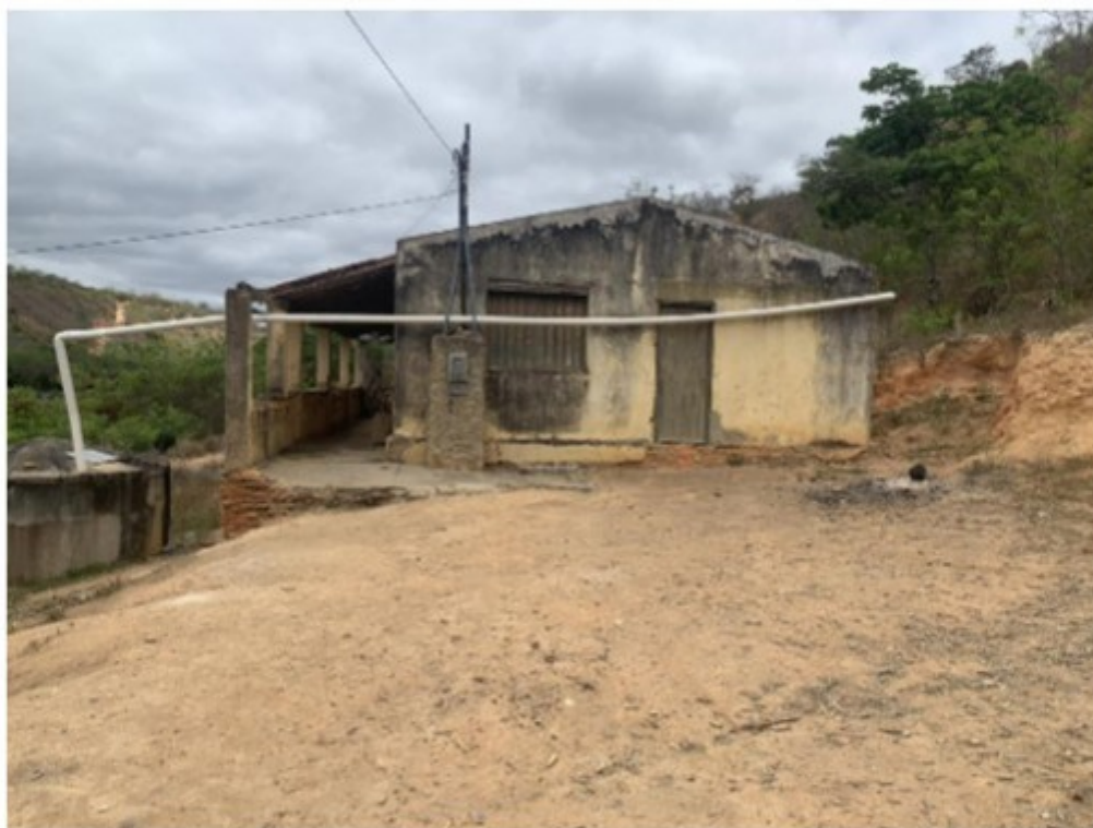
Edificação que serviria de alojamento à suposta vítima de trabalho análogo ao de escravo
