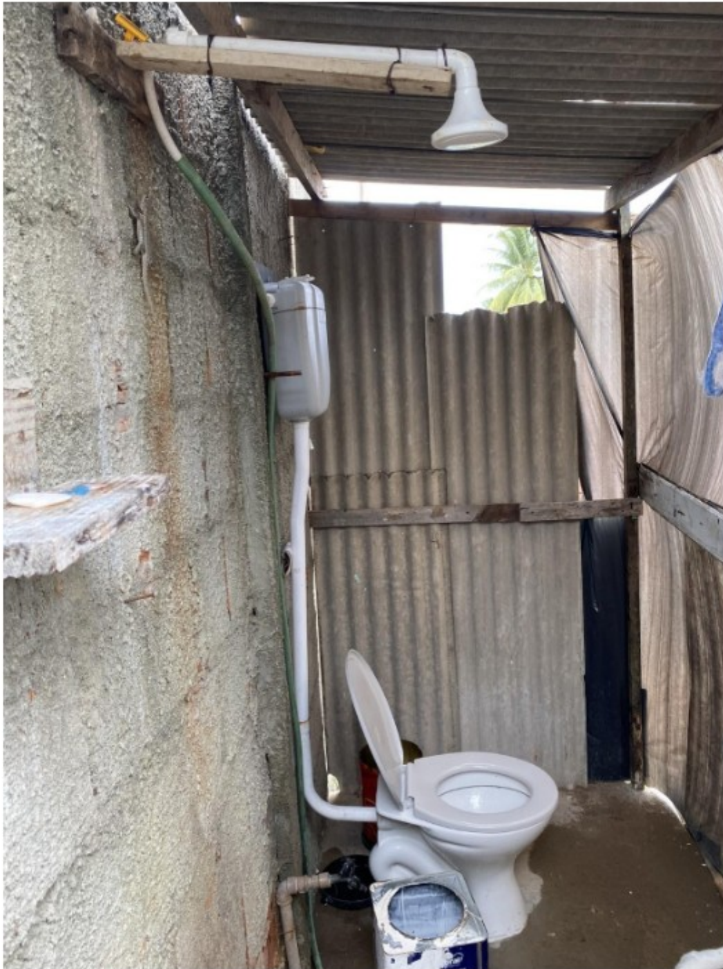
INTERIOR DO BARRACO / INSTALAÇÃO SANITÁRIA
