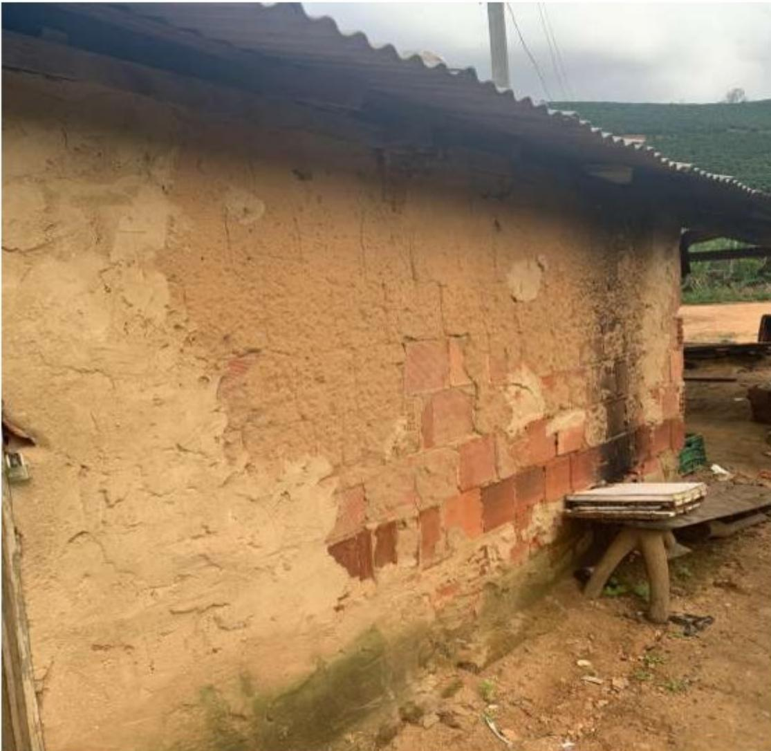
*Detalhe da parte externa de uma das casas com a cobertura que permitia vazamentos*
