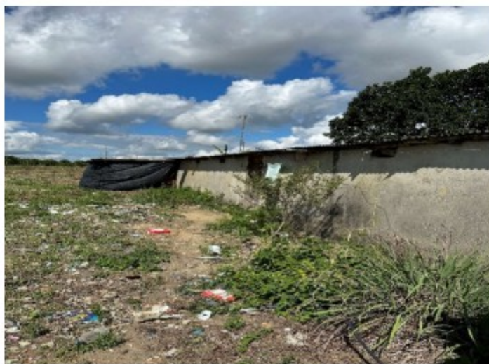
Figura 6 - Condições impostas pelo empregador levavam a armazenar dejetos ao lado do alojamento
