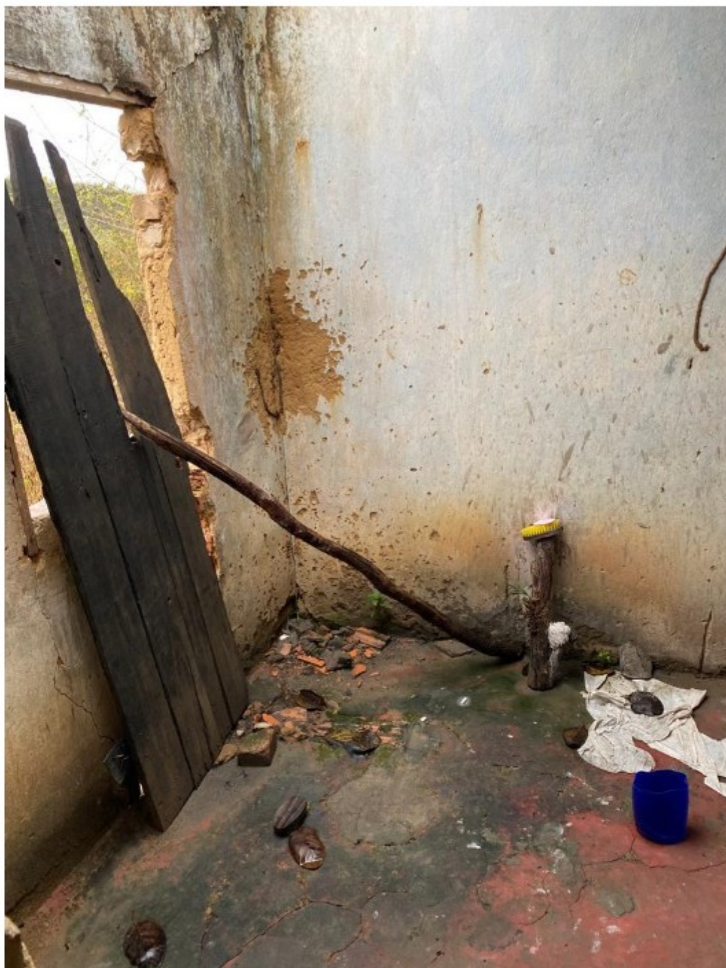
Local de banho dos trabalhadores
