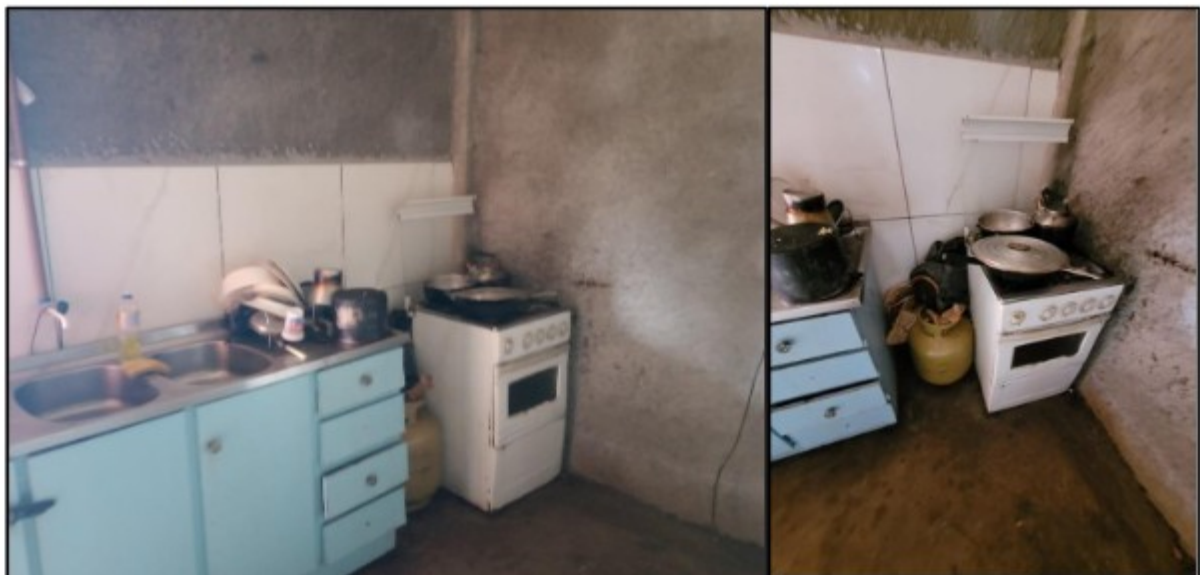
Figura 9 – Recipiente de armazenagem de gás liquefeito de petróleo - GLP (botijão tipo P-13) instalado em área interna do alojamento (cozinha).
