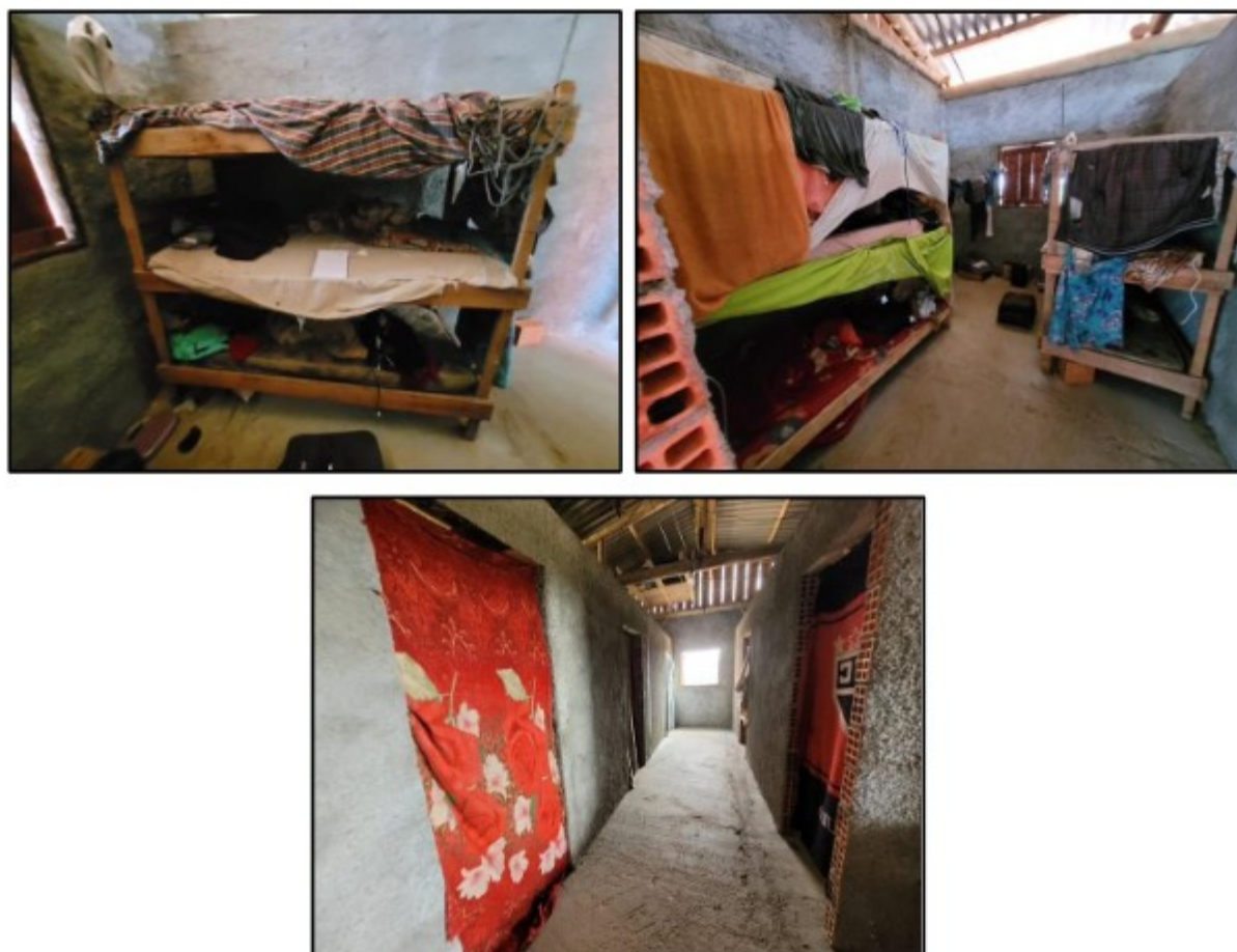
Figura 4– Acima e à esquerda treliche sem proteção lateral e escada afixada na estrutura. Acima e à direita imagem do quarto sem armários individuais para todos os ocupantes. Abaixo, corredor de acesso aos quartos sem portas, com cobertores improvisados.
