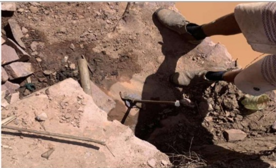
Preparação do explosivo
