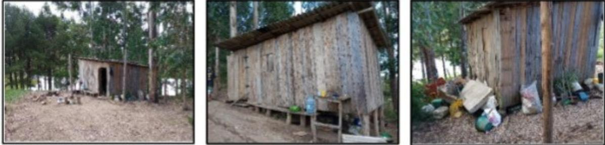
Figura 10– “Meia água” de madeira onde os trabalhadores estavam alojados, preparavam e tomavam as refeições, além de dividir o espaço com os produtos tóxicos, e sem instalação sanitária.
