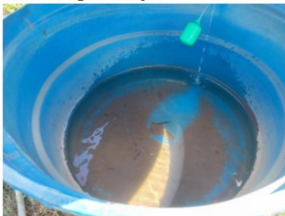
Foto: caixa d'água do alojamento no momento da fiscalização
