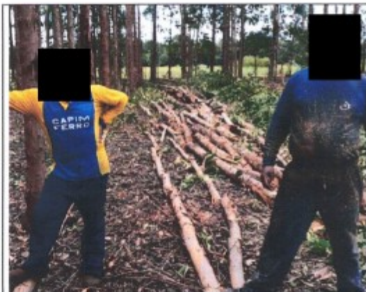
Foto 21 - trabalhadores na frente de trabalho sem os EPI e dispositivos de proteção pessoal necessários para a atividade.
