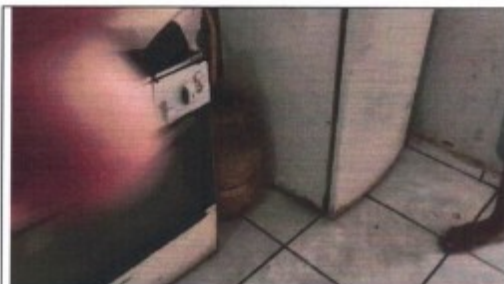
Foto 11 - Armazenagem de gás liquefeito de petróleo (GLP) na área interna do imóvel, mais especificamente ao lado do fogão.
