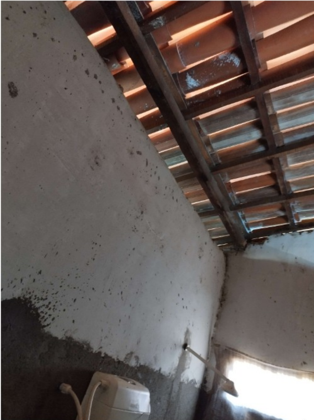
Frestas entre o telhado e as paredes, permitindo a entrada de animais.
