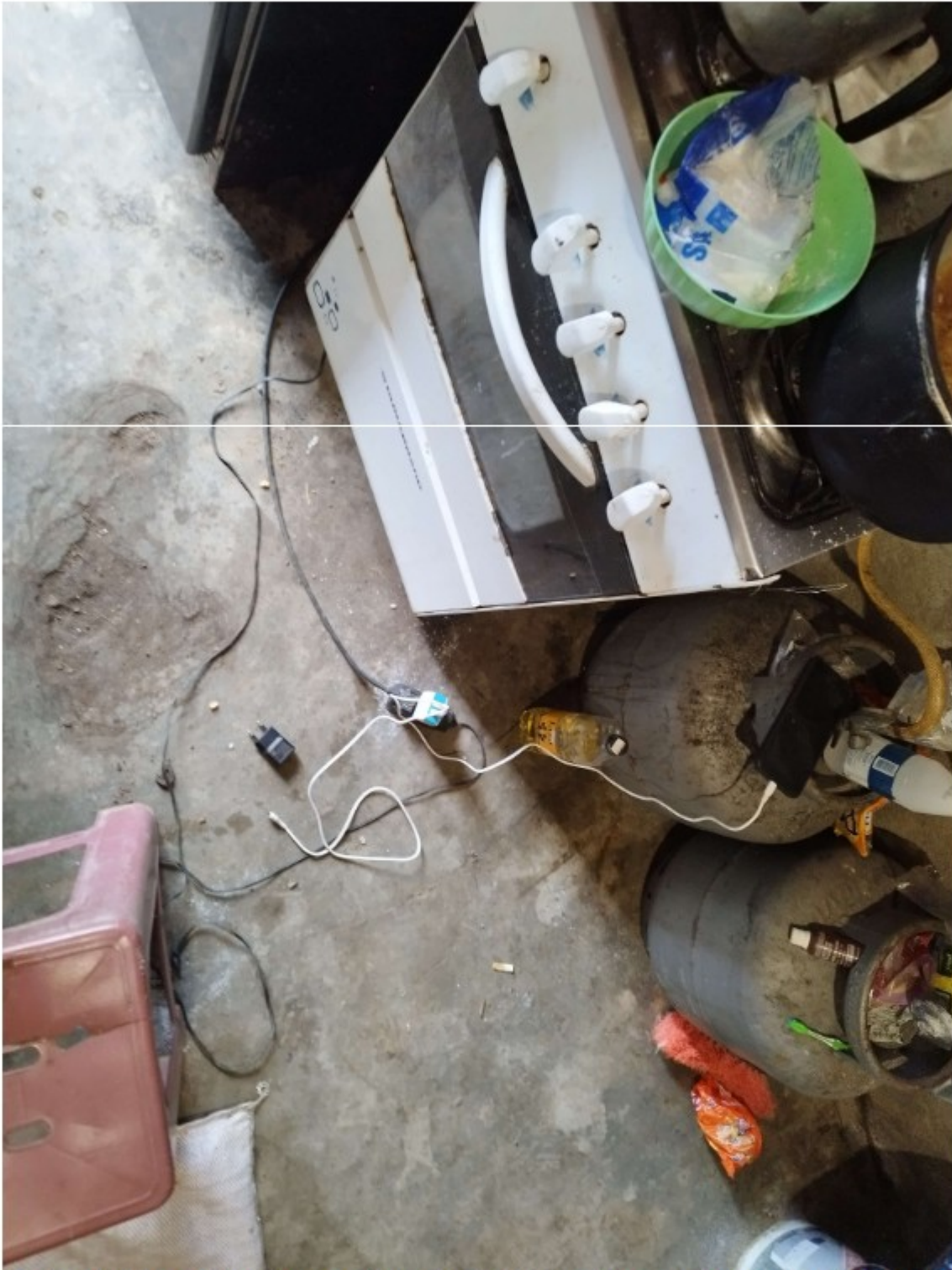
Extensão elétrica pelo chão para ligação dos aparelhos em uma única tomada. Piso com irregularidades que favorecem o acúmulo de sujeiras.
