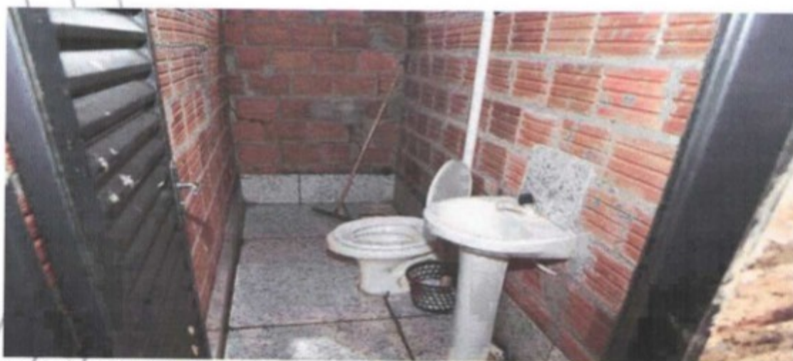
Instalação sanitária no alojamento sem funcionamento do vaso de descarga no momento da inspeção física
