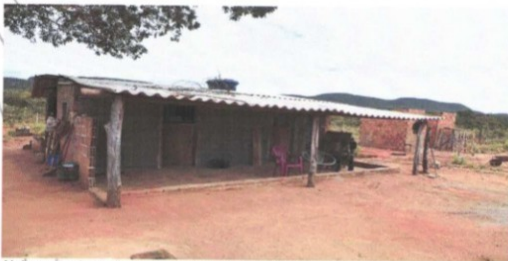
Alojamento dos trabalhadores no momento da inspeção física
