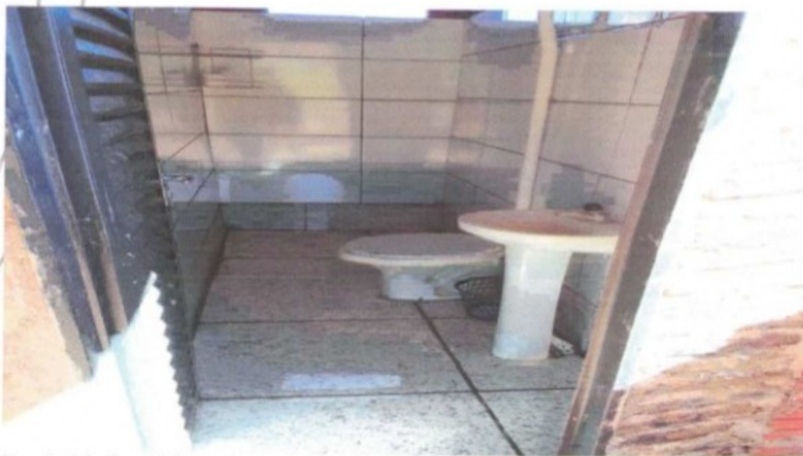
Nova instalação sanitária com vaso funcionando
