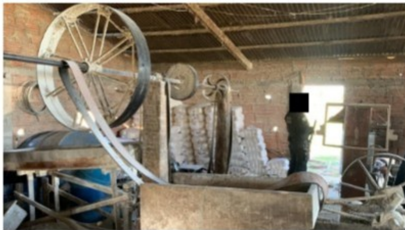
Máquinas sem proteção ou aterramento
