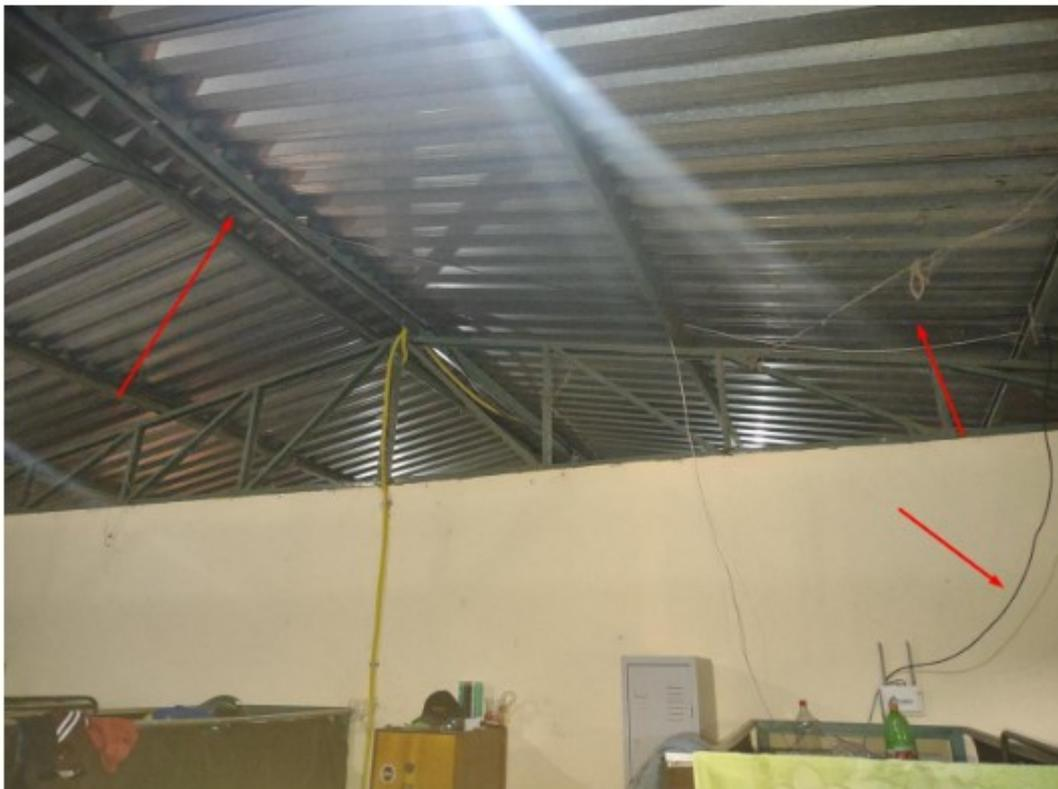
Alojamentos maiores onde estavam alojados 10 a 12 trabalhadores por quarto, fiação elétrica fora de eletrodutos ou eletrocalhas. Nas setas vermelhas vemos fios elétricos fora de eletrodutos ou eletrocalhas.
