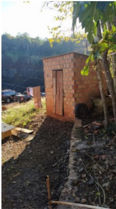
(vista externa do banheiro)
