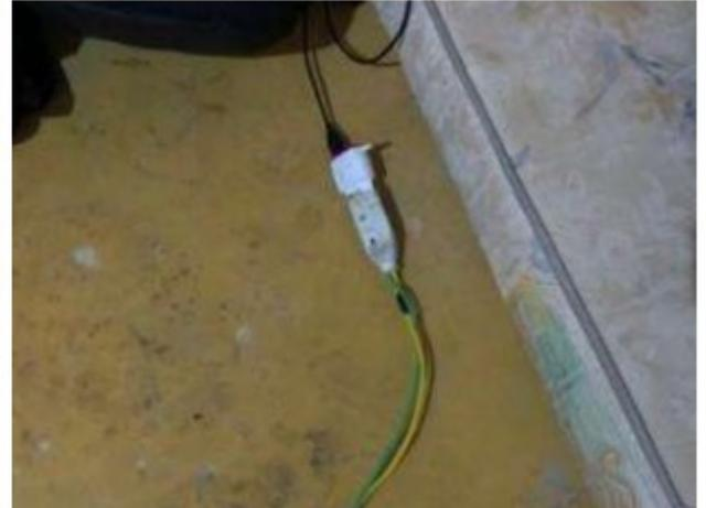
Instalações elétricas completamente inadequadas, sujeitas a curto circuito e choque elétrico.
