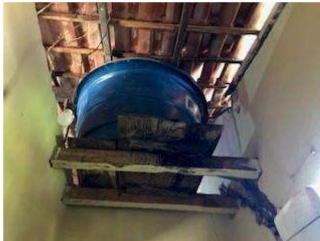
Caixa d'água passando umidade para o madeiramento que a sustenta.
