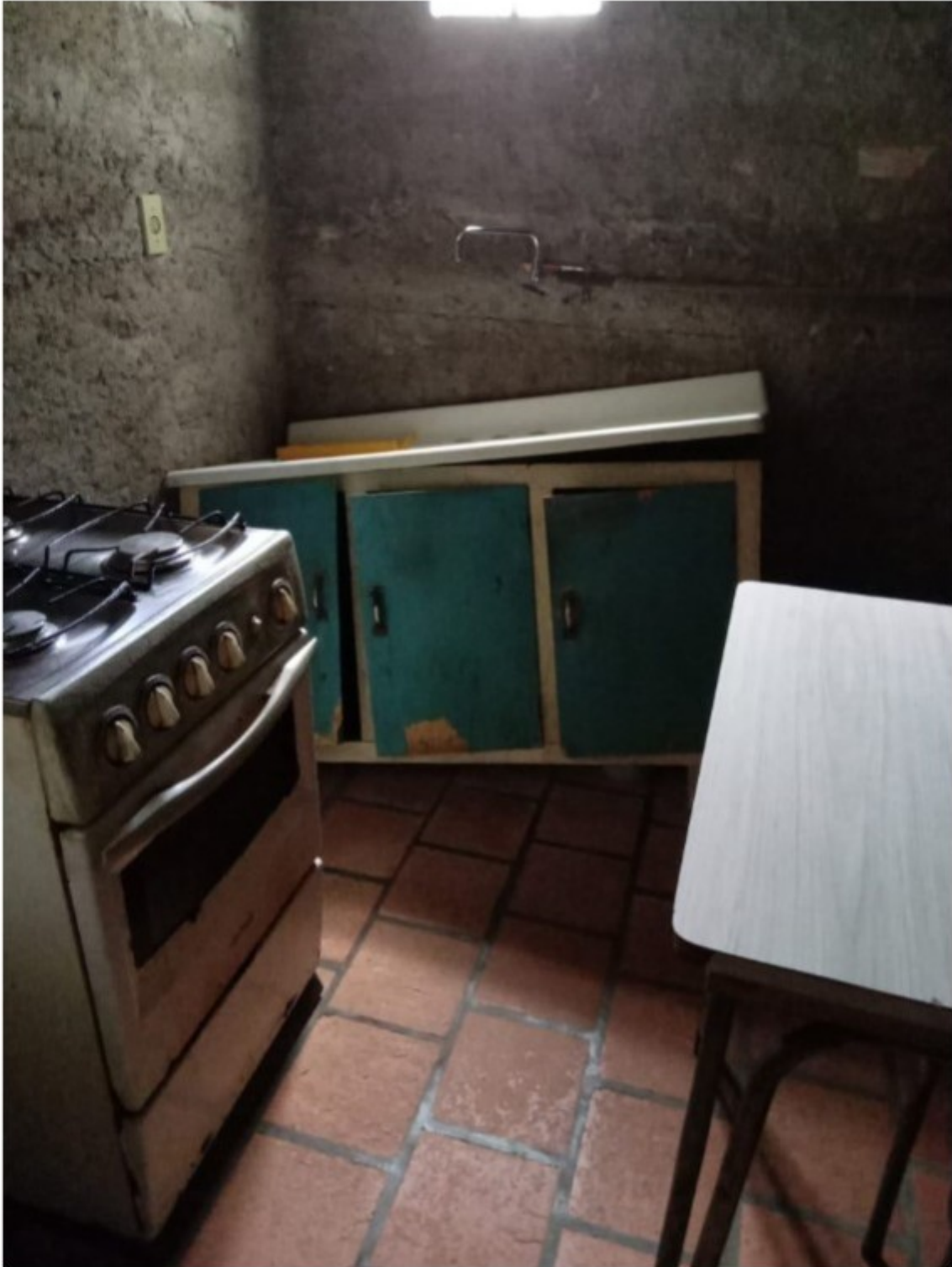
Foto tirada pela Polícia Civil de Garibaldi, em 31 de janeiro de 2023, da mesma cozinha do estacionamento citada na foto anterior. A foto mostra a bancada da pia da cozinha do estacionamento com bancada desnivelada e desacoplada do resto do armário da pia, evidenciando que, sim, havia deficiência na conservação de tal cômodo do estabelecimento inspecionado.
