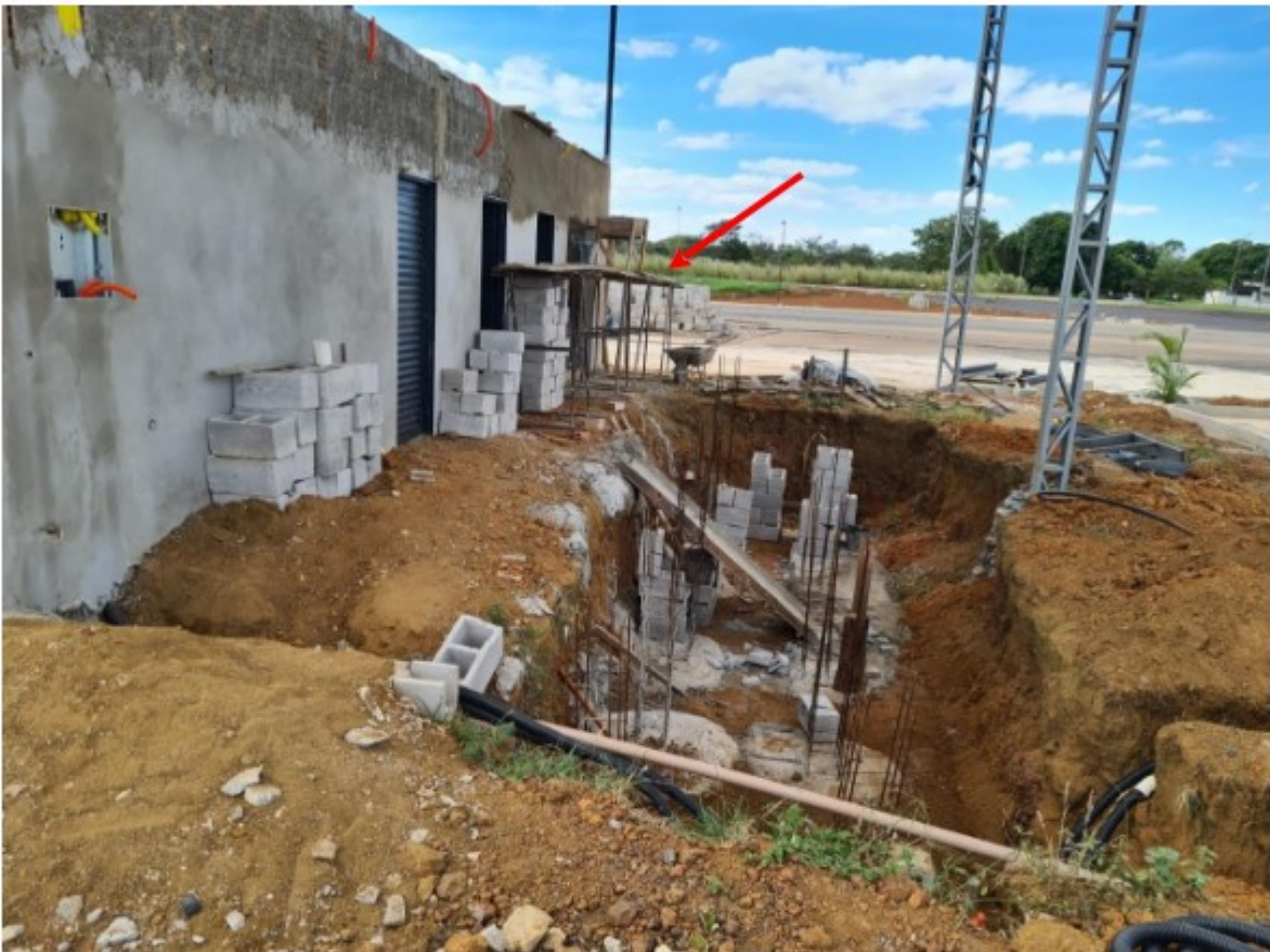
Foto 17. Vista lateral do prédio em construção que abrigará os vestiários, borracharia e rampa de troca de óleo. Ao fundo, indicada pela seta vermelha, está a plataforma de trabalho instalada nas proximidades da escavação, com pontas verticais de vergalhões oferecendo risco de acidentes.
