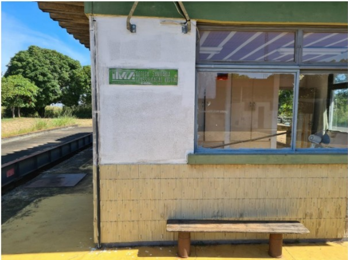
Foto 8. Vista da face lateral do prédio utilizado pelos trabalhadores como alojamento improvisado. Registro efetuado em 09/05/2023.
