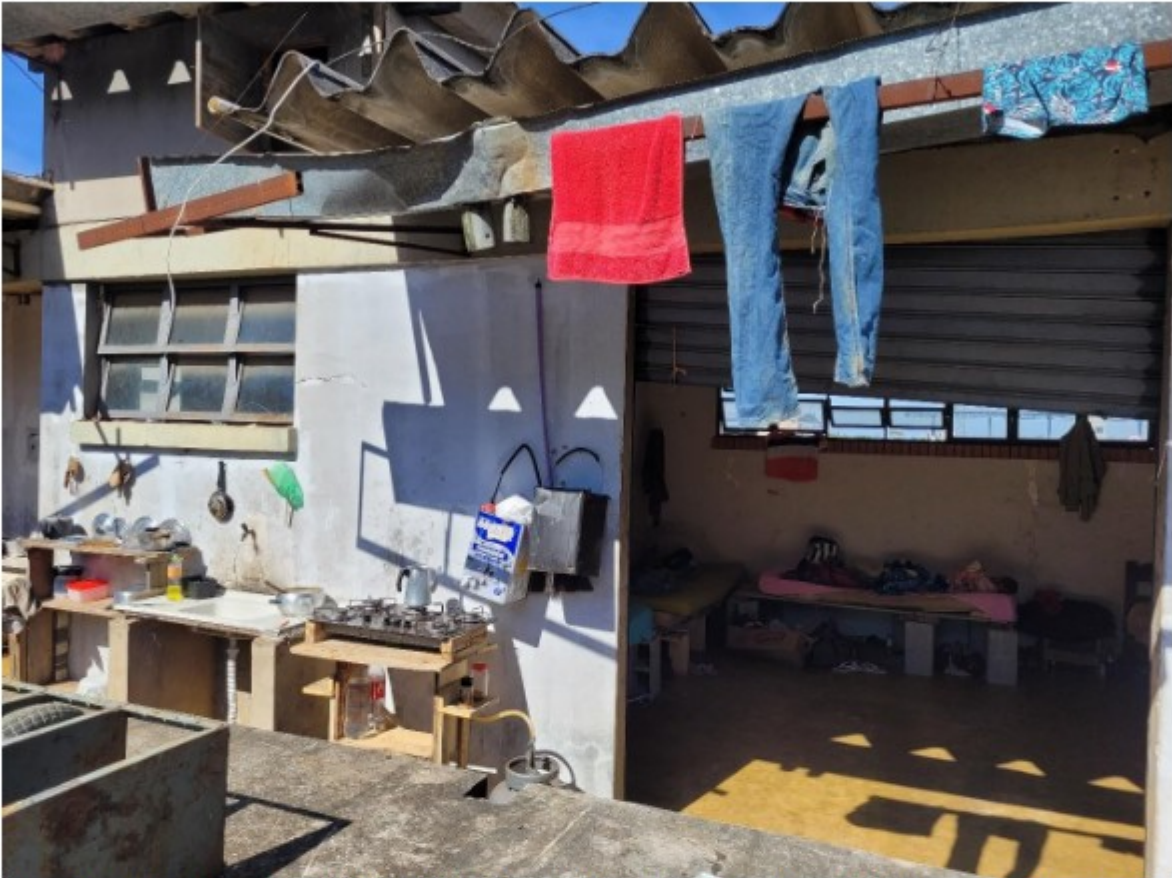
Foto 15. Vista externa do depósito utilizado como dormitório por seis trabalhadores. Registro efetuado em 09/05/2023.
