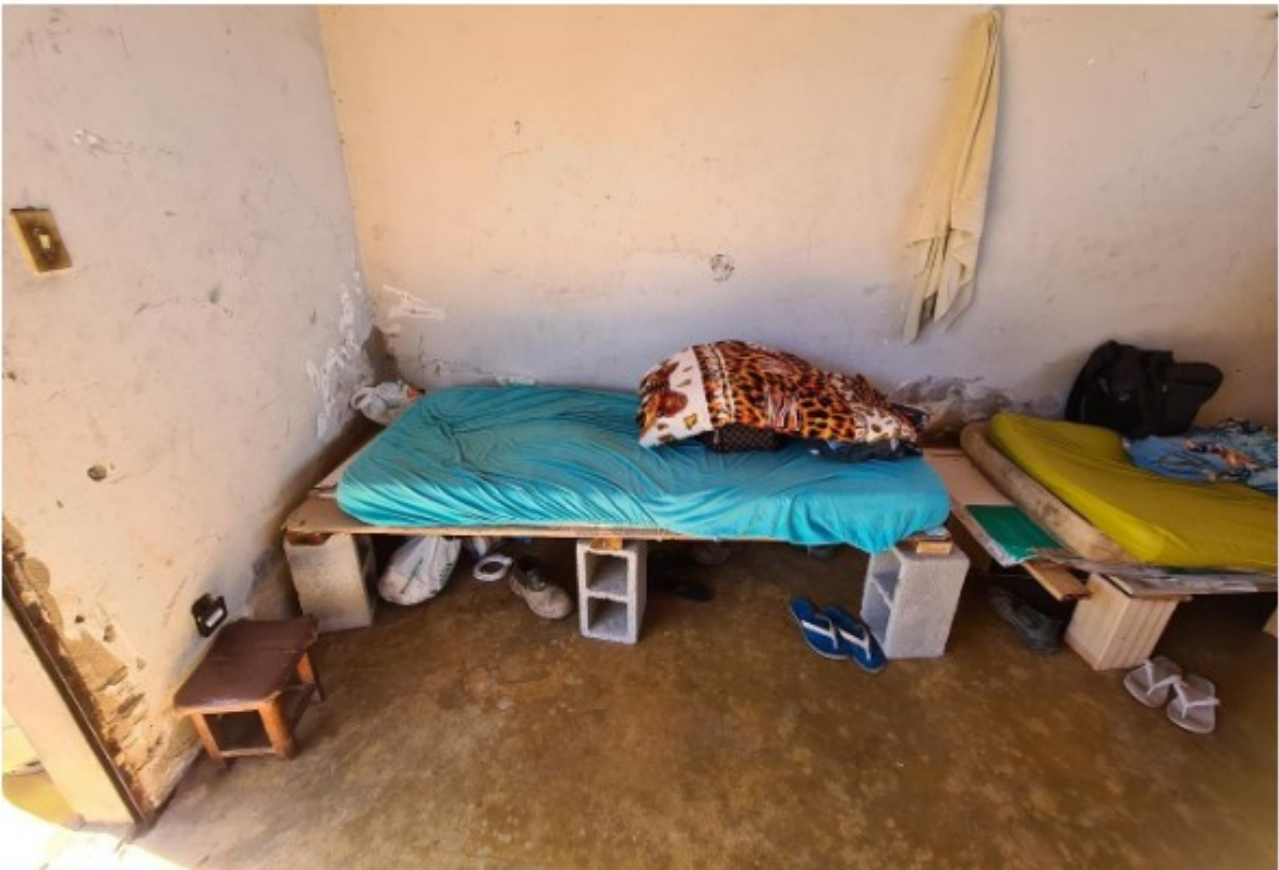
Foto 12. Vista do depósito utilizado como dormitório por seis trabalhadores. É possível ver camas improvisadas com tijolos, tábuas e pedaços de papelão. Registro efetuado em 09/05/2023.
