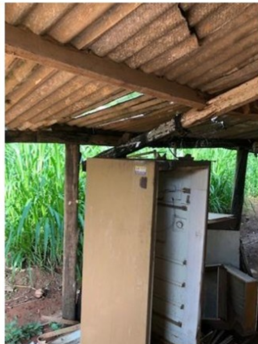
Improvisos no alojamento, equipamentos e combustível na sala do alojamento e geladeira estragada servindo de sustento do telhado na varanda
