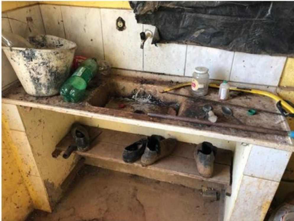
Banheiro sem condições de uso do alojamento da Fazenda JB
