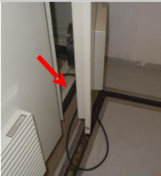
Porta de acesso a quadro ou painel de comando e potência de máquinas e equipamentos aberta
