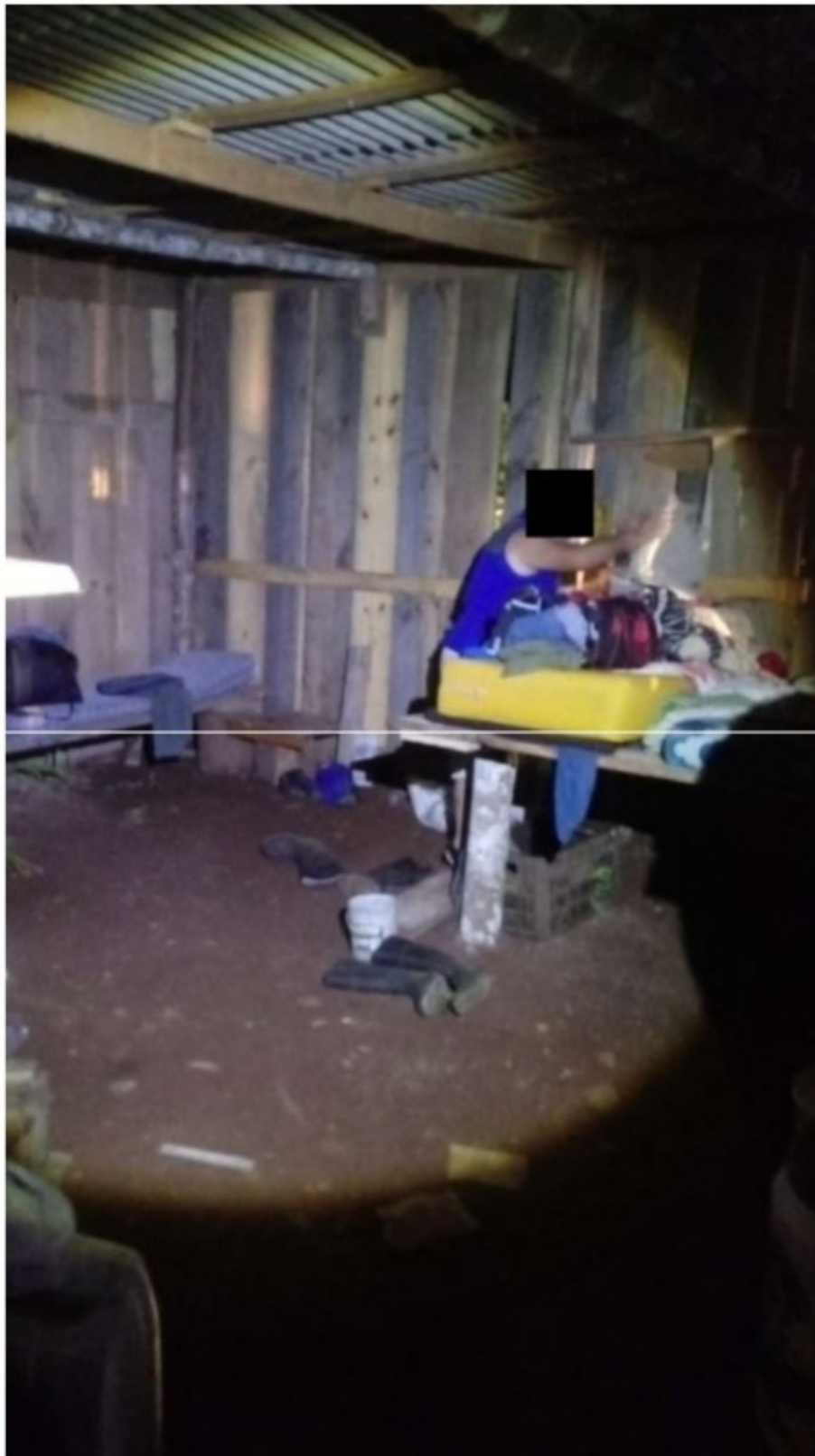
Foto interna do alojamento da Linha Olinda, retirada enquanto o empregado [REDACTED] recolhia seus pertences pessoais. Notam-se claramente a ausência de piso e armários, assim como o improviso de suportes que funcionavam como camas para apoio dos colchões nos quais os empregados ali alojados dormiam
