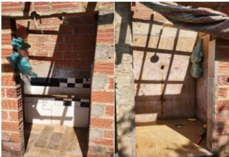
Figura 8: mictório usado pelos trabalhadores; Figura 9: gabinete onde os trabalhadores tomavam banho.
