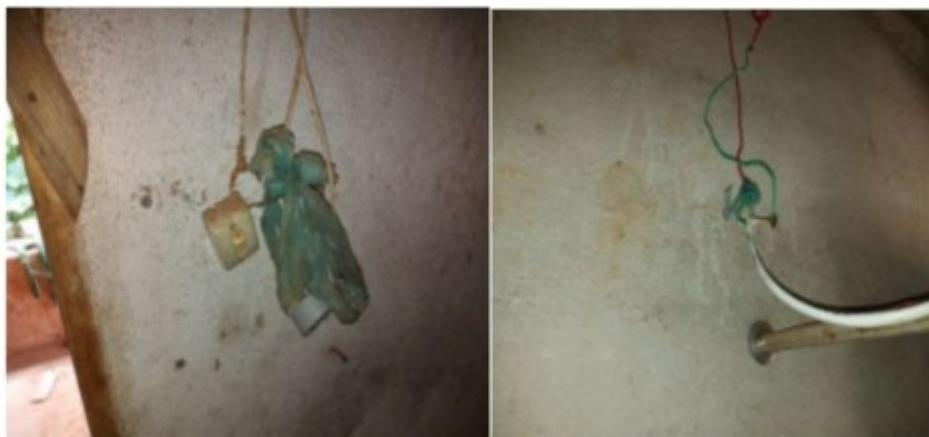
Figuras 1 e 2: emendas improvisadas e ligação inadequada no chuveiro
