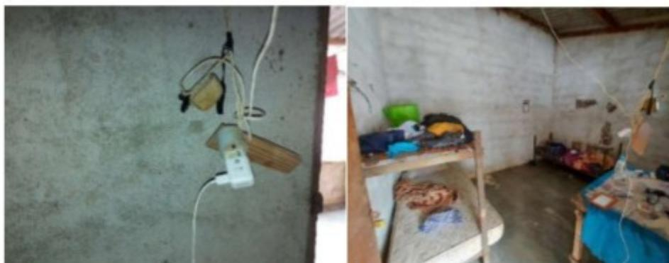
Figuras 3 e 4: emendas improvisadas e fiação baixa desprotegida.
