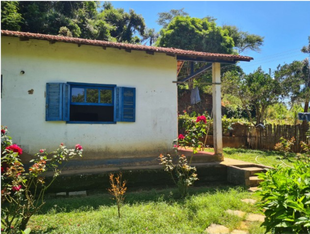
Moradia Familiar dos trabalhadores
