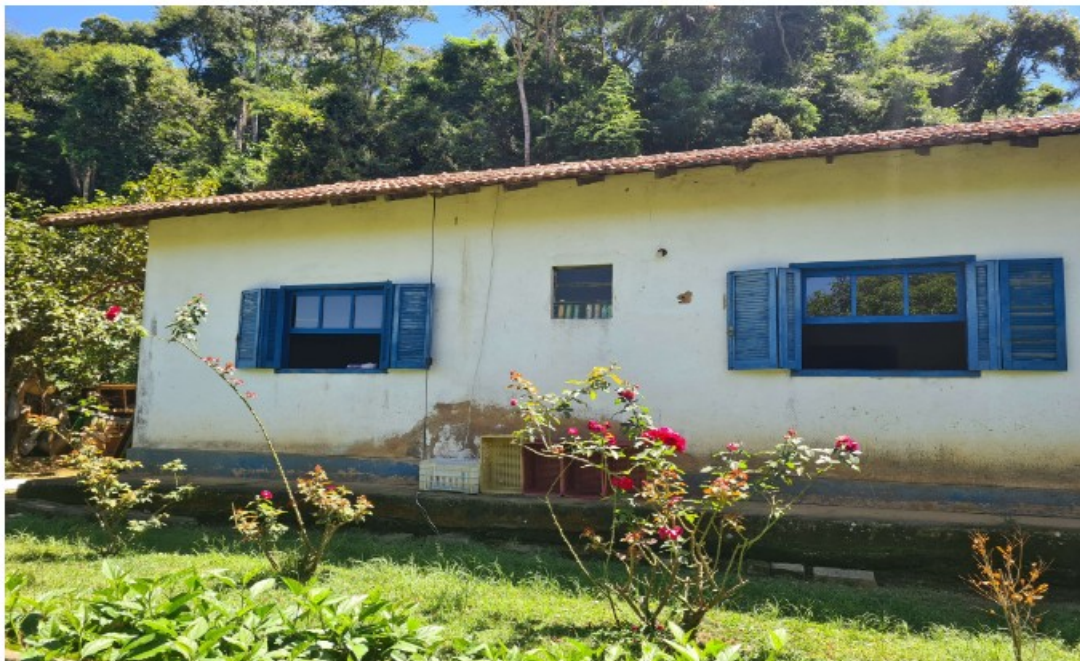
Moradia Familiar dos trabalhadores
